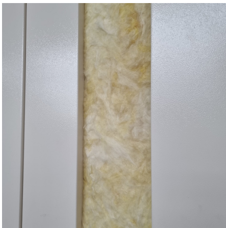
Caixa isolada, feita de painéis facilmente removíveis
